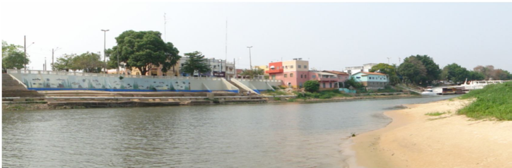
Imagens 1 e 2 – Cais da Braça Barão do Rio Branco, Cáceres – MT
